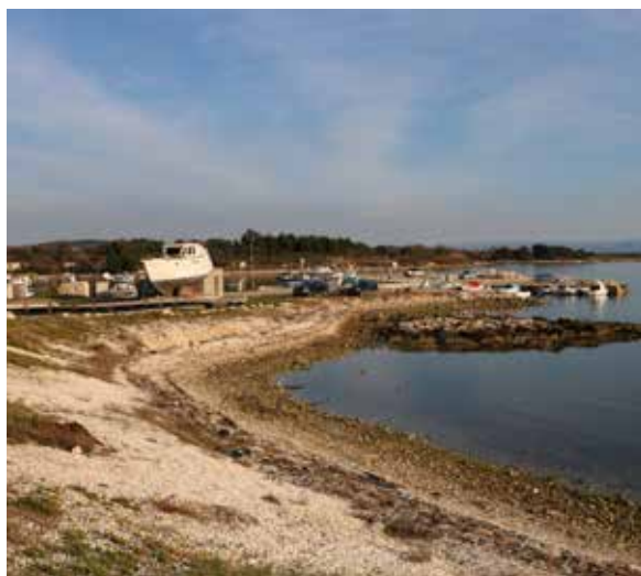
Slika 10: Dio šljunčane plaže uz sjeverni mol- nanos otpada
