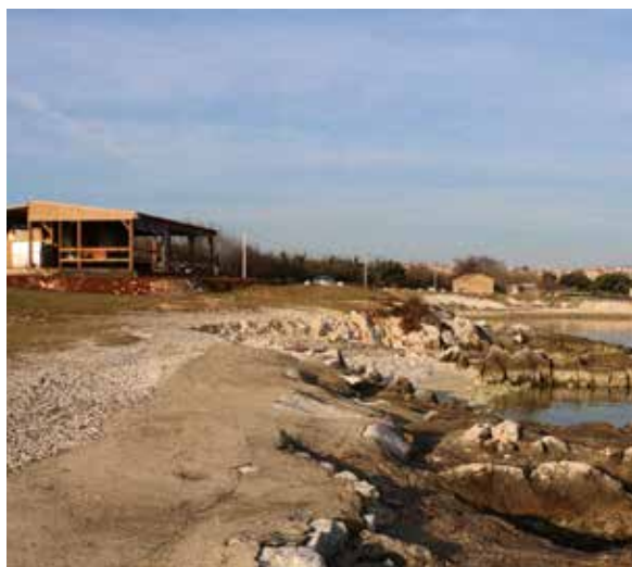
Slika 12: Betonski dijelovi plaže
